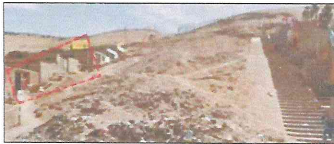
Construcción empírica e insegura de viviendas
