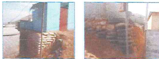
Casas construidas sobre bolsas de cemento relleno de material de la zona, llantas y piedras
