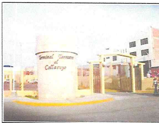
Terminal Terrestre El Collasuyo
